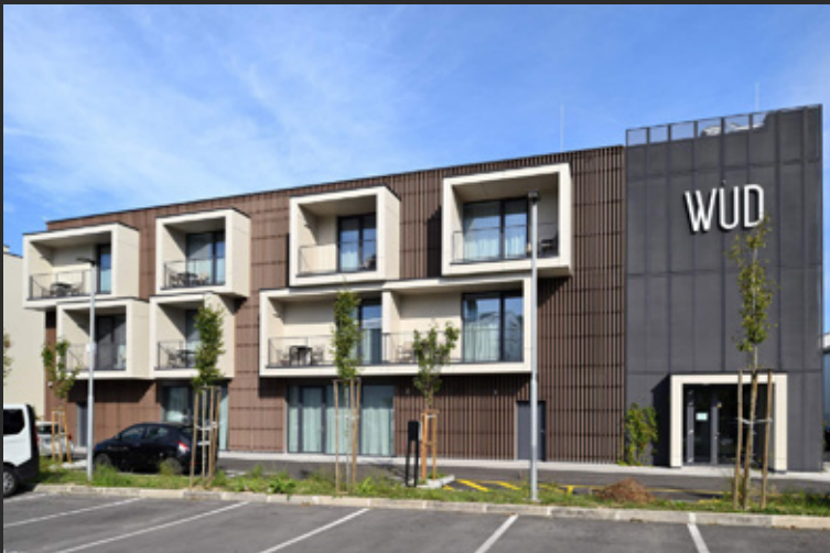
Hotel WUD - Slovenia Architect: SoNo Arhitekti, Obrat
