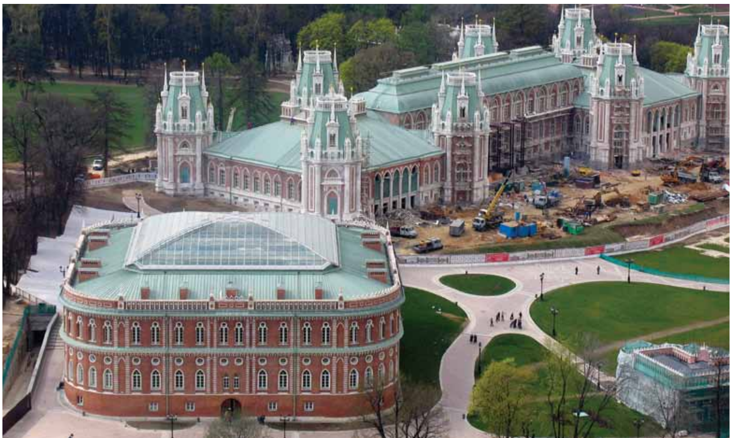
Большие площади с длинными кровельными картинами, произведенными из патинированной в заводских условиях меди Нордик Грин на кровле дворцовых зданий в Царицыно в Москве.
